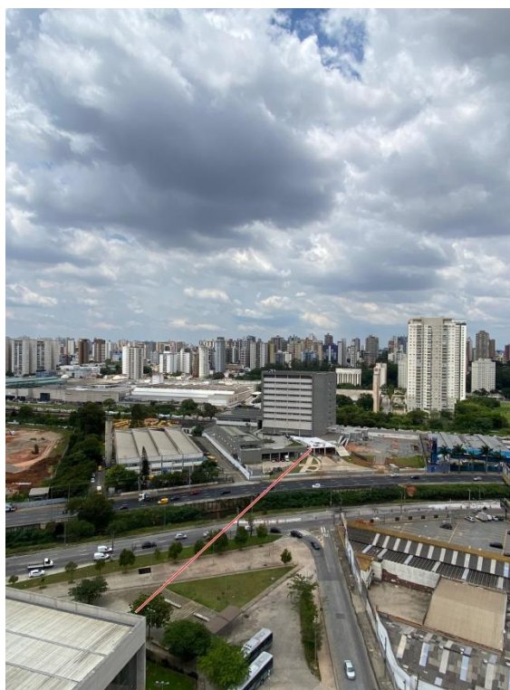
Figura 07: Visão do trecho da futura Passarela. UFABC Campus Santo André.
