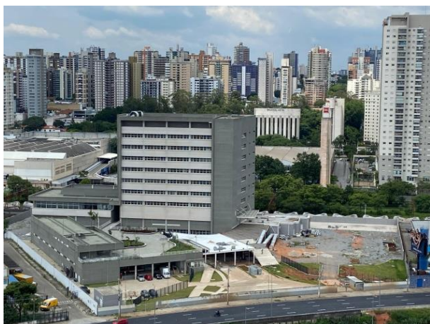
Figura 01: Visão atual da obra. UFABC Unidade Tamanduatehy.
